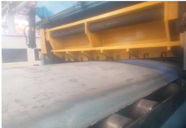
Figura 6. Área del proceso donde puede dañarse las placas de acero. Zona de contacto con la guillotina o cizaña
